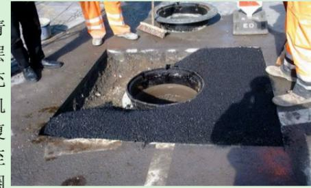
图10 分层填筑沥青混合料
