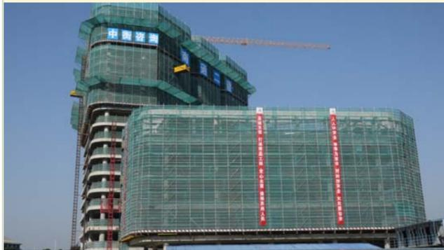
面积56566.55 m<sup>2</sup>，地下建筑面积20198.02 m<sup>2</sup>；地下2层、主楼24层、裙房4层，框架-剪力墙结构；建筑主体高度99.85m，属一类高层民用建筑。安全文明施工目标等级：“省级文明工地”。
