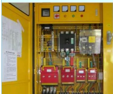
三级配电、二级漏保保护系统参考图例
