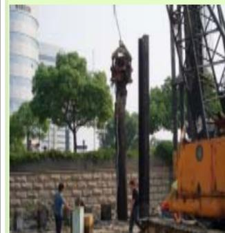
(1) 检查H型钢表面质量，必须平整光滑，直线度在1.0%以内，型钢插入搅拌桩前必须在表面必须清洗干净，均匀涂刷减摩剂。H型钢的减摩，是H型钢插入和顶拔顺利进行的关键工序，监理工程师应加强对型钢表面减摩剂涂刷质量的检查：
