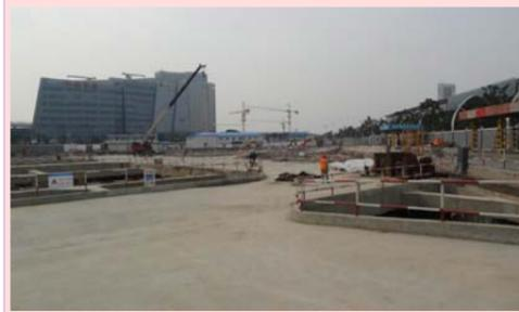
左图深基坑临边虽然有200mm高混凝土翻边且有钢管栏杆，但超过200mm以上漏空的尺寸太大，一旦临边堆材料
