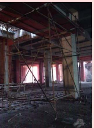
上图：移动工具式脚手架，轮子没有刹车，也没有上下爬梯，不规范。
